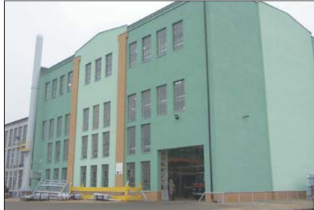
Zmodernizowany dzięki dotacjom UE wydział cynkowni ogniowej
