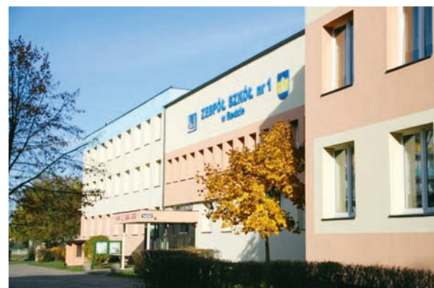
Termomodernizacja budynku Zespołu Szkół nr 1 w Redzie
