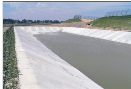
Zakład Unieszkodliwiania Odpadów Komunalnych w m. Borownica
