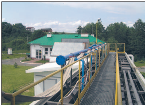
Oczyszczalnia ścieków typu mechaniczno-biologicznego w m. Modliborzyce
