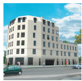
Budynek mieszkalno-usługowy przy ul. Wiejskiej w Białymstoku
