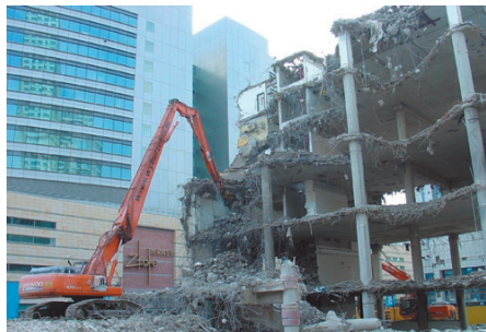
Wyburzenie galerii handlowej CITY CENTER w centrum Warszawy przy ulicy Złotej
