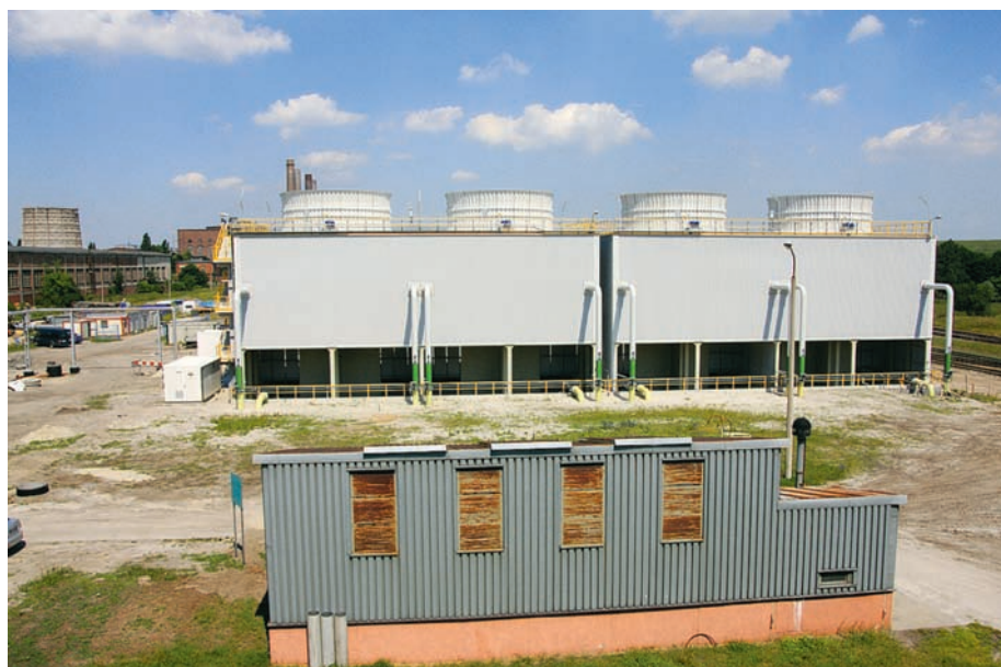
Chłodnia wentylatorowa instalacji TK V
