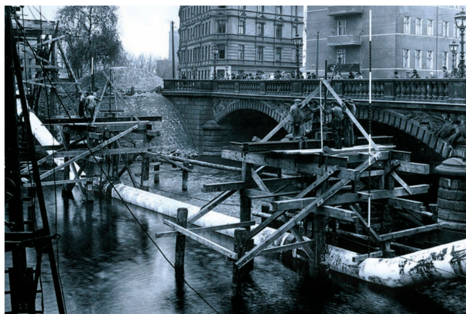
Budowa magistrali wodociągowej pod mostem Olawskim (zdjęcie z pocz. XX w.)
