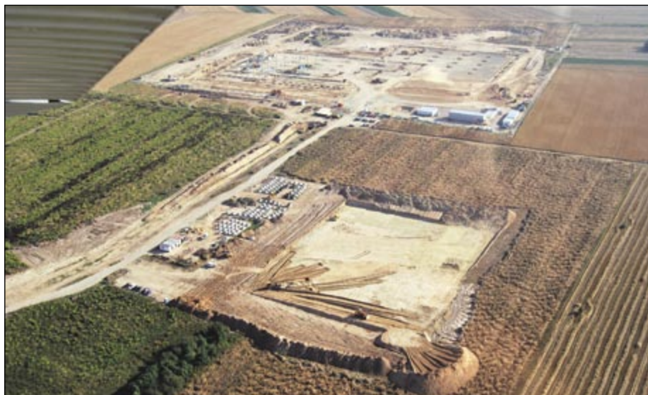
Pierwsi inwestorzy rozpoczęli prace budowlane na terenie Strefy
