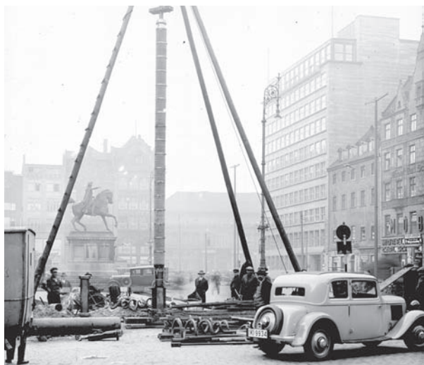
Prace wiertnicze przy studni publicznej na wrocławskim rynku, lata 30. XX wieku
