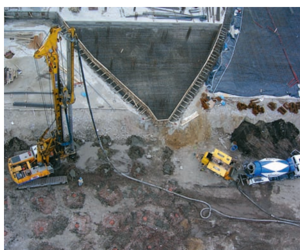
Wzmocnienie słabego podłoża organicznego, kolumnami CMC pod 14-kondygnacyjny budynek w Warszawie
