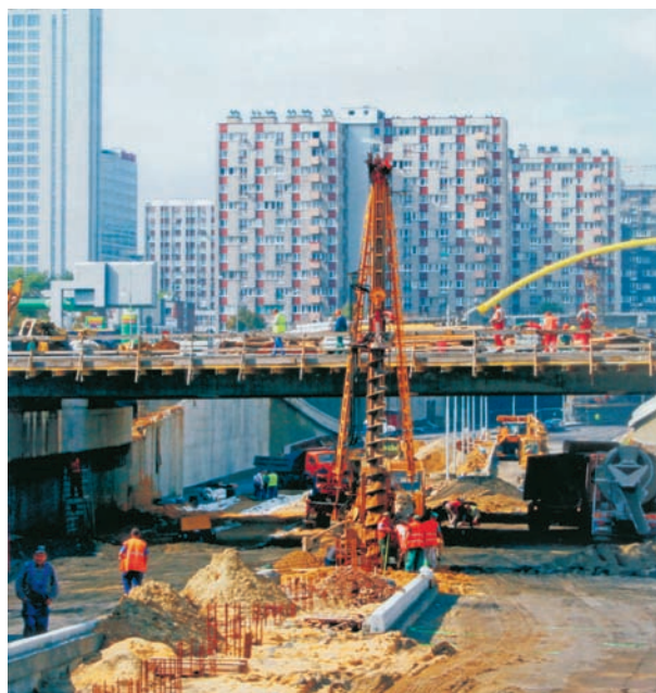
Wykonanie pali przy drodze do tunelu pod Rondem Generała Jerzego Ziętki (Katowice Al. Roździeńskiego)
