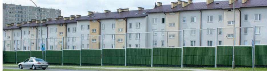
Budowa ekranów akustycznych w Tarnowie
