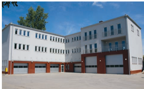
Centrum Diagnostyki i Serwisu Urzędzeń Bezpieczeństwa Ruchu Kolejowo-Drogowego firmy SABEL
