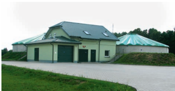
Oczyszczalnia ścieków w miejscowości Trojanów
